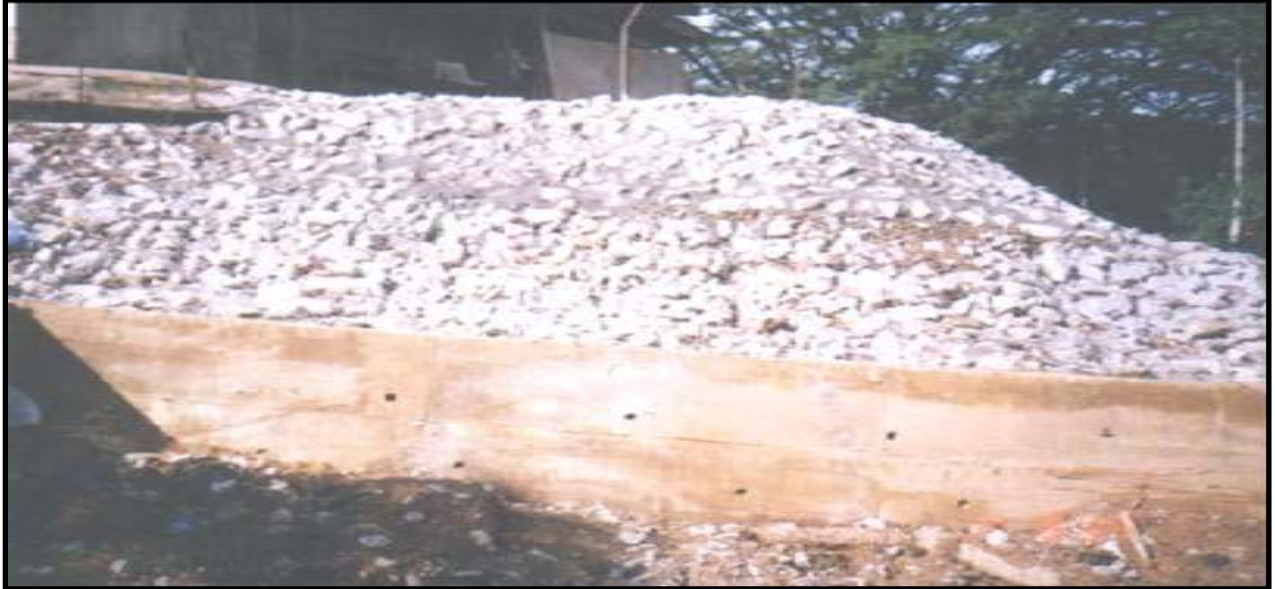
Gambar 4 : Sg. Kerukut @ Kuala Krai - Struktur 'Stone Pitching'
