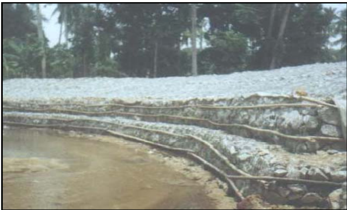
Gambar 1 : Sg. Geh @ Kg. Telekong - Struktur 'Gabion'
