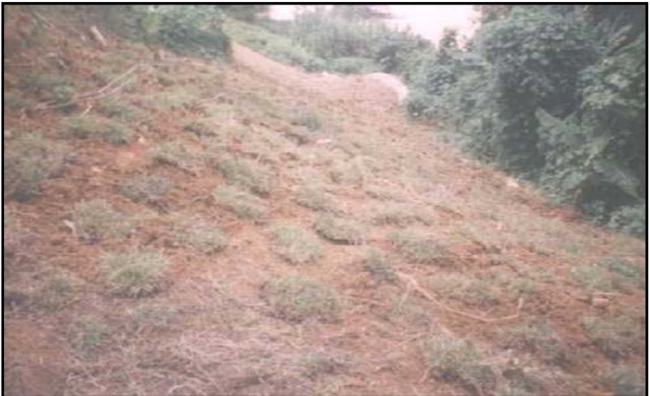
Gambar 3 : Sg. Kelantan @ Kg. Batu Lada - 'Turfing'
