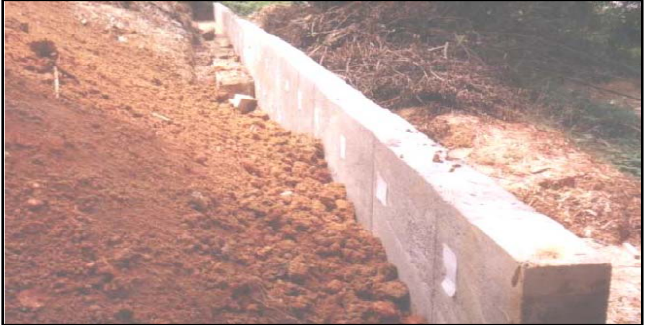
Gambar 2 : Sg. Kelantan @ Kuala Krai - Struktur 'Retaining Wall'
